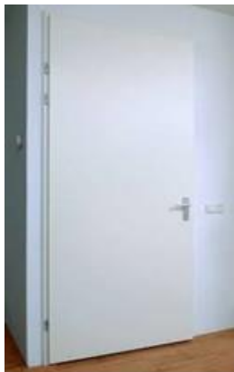
hardhouten binnendeurkozijn zonder bovenlicht met opdekdeur
